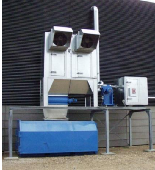
Resim 2.13: Kabinden atılan kirli hava filtreleme sistemi
