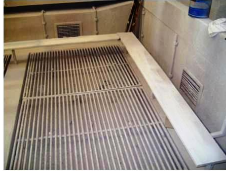
Resim 2.16: Kabin tabanında bulunan ızgaralar
