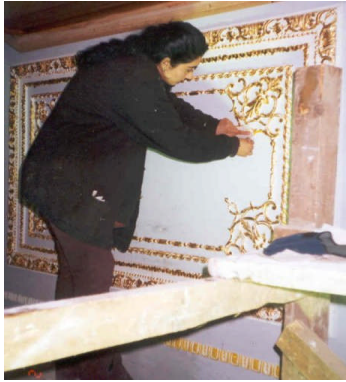
Resim 3.3: Altın varak çalışmaları
