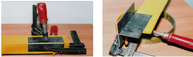
Resim 3.1: İç köşe kaynaklarının kaynağa hazırlanması
