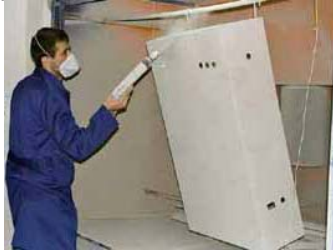
Resim 5.14: Uygun mesafeden malzeme yüzeyinin boyanması
