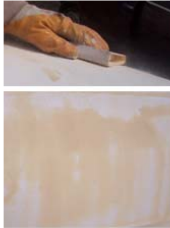
Resim 2.6: Macunlama sonrası zımparalama ve zımparalanmış yüzey
