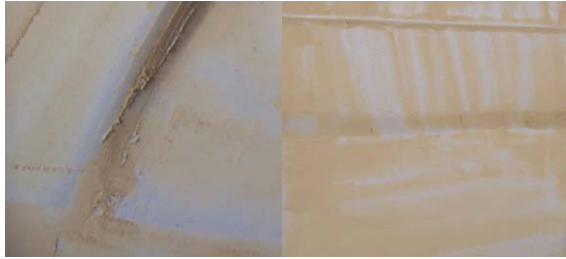
Resim 2.3: Zımparalama öncesi ve zımparalama sonrası macunlu yüzey
