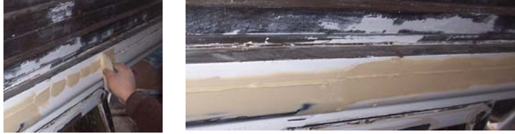
Resim 2.5: Hazırlanan macunun spatula ile sürülmesi
