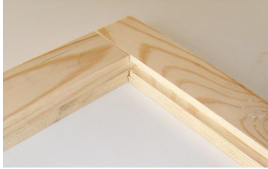
Resim 2.6: Açık zıvanalı 2/3 lambalı çerçeve köşe birleştirme
