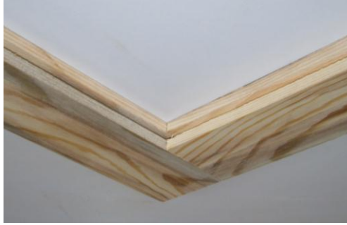
Resim 2.5: Açık zıvanalı kınışlı çerçeve köşe birleştirme
