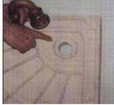
Resim 5.6: Sifonu bağlantıya hazırlama
