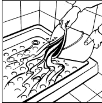
Şekil 5.11: Sızıntı kontrolü yapma işlemi
