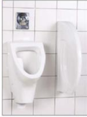
Montajı tamamlanmış ara bölme.
