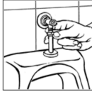
Şekil 3.5: Pisuar montajı
