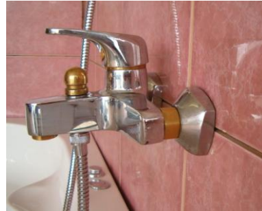
Resim 5.12: Duvar tipi sıva üstü banyo bataryası
