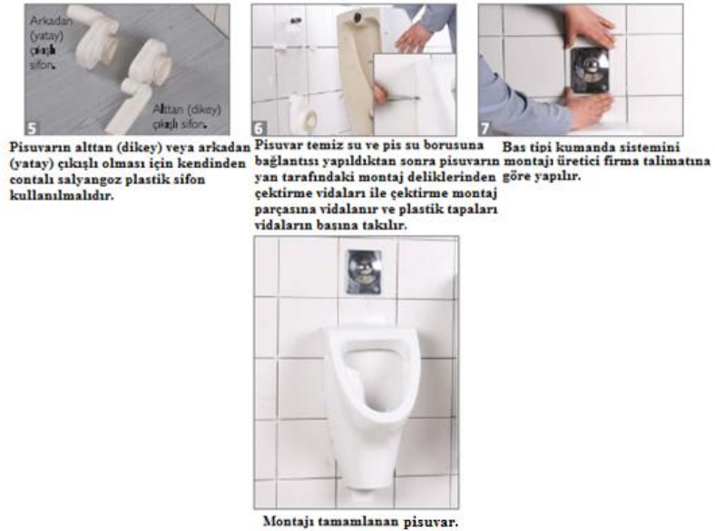
Resim 3.14: Yandan montaj setli pisuvar montaj basamakları
