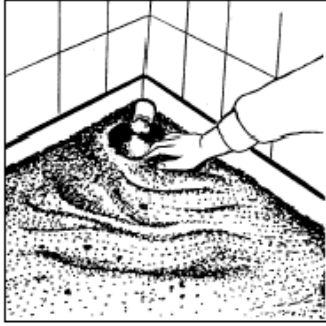
Şekil 5.4: Duş teknesinin zeminini hazırlama tesviyeleme
