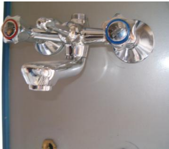
Resim 5.12: Duvar tipi sıva üstü banyo bataryası
