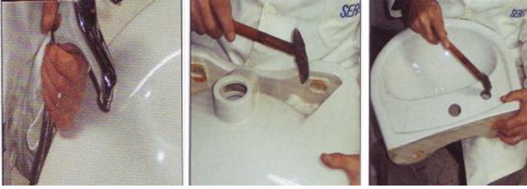
Resim 2.4: Lavabo armatür deliğinin açılış şekli
