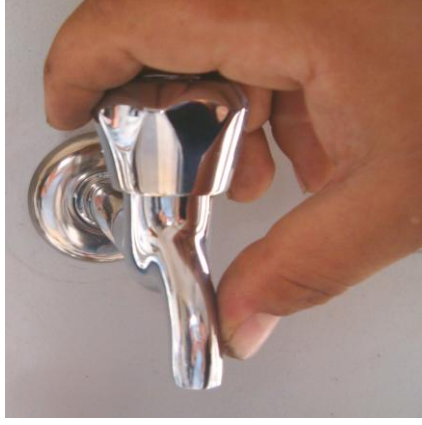
Resim 1.16: Yerine montaj edilmiş musluk
